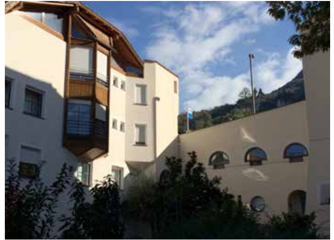
An den Fassaden des Dorfzentrums wurden dringend notwendige Sanierungsarbeiten durchgeführt
