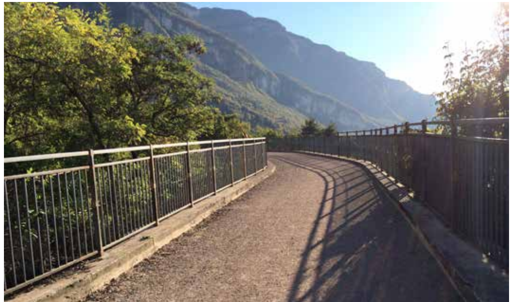
Mit der Fertigstellung eines weiteren Teilstückes des Radweges wurde auch das Geländer der Glenner Brücke verbessert.
