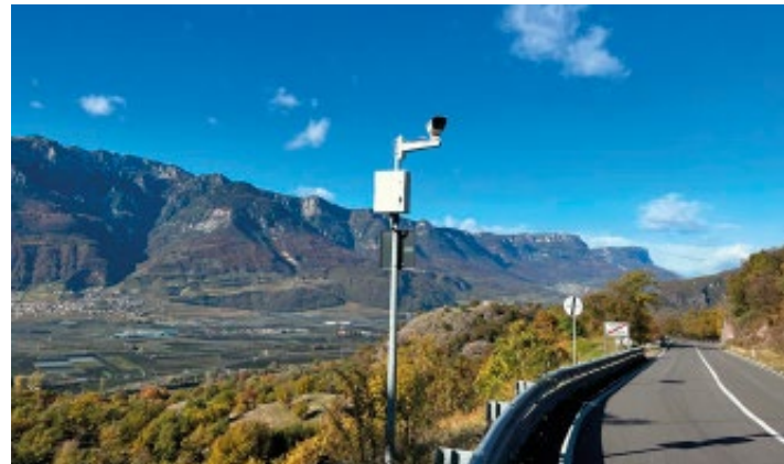
Die Kamera zur Kennzeichenerkennung der Fahrzeuge an der Dorfeinfahrt an der Dolomitenstraße (Auer Richtung Montan)
