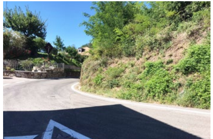
An dieser Stelle wird die Kurve an der LS 59 in Glen entschärft.
