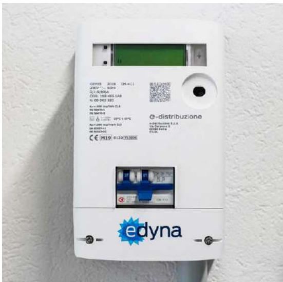
Edyna wird in Montan neue Stromzähler anbringen
