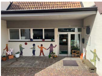
Während der Sommerferien wird der Kindergarten saniert
